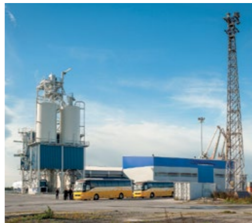
Uusi terminaali käsittelee kalkkia noin 100 tonnia tunnissa, ja lopputuote varastoidaan kahteen 30 metriä korkeaan silloon.
